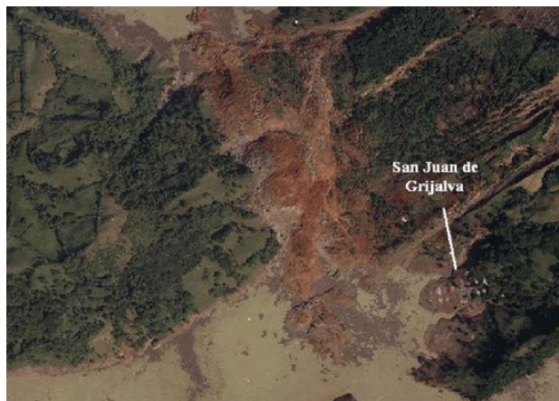
Figura 2. Fotografía aérea del deslizamiento de talud en la comunidad San Juan de Grijalva. Fuente: Comisión Federal de Electricidad (CFE)
