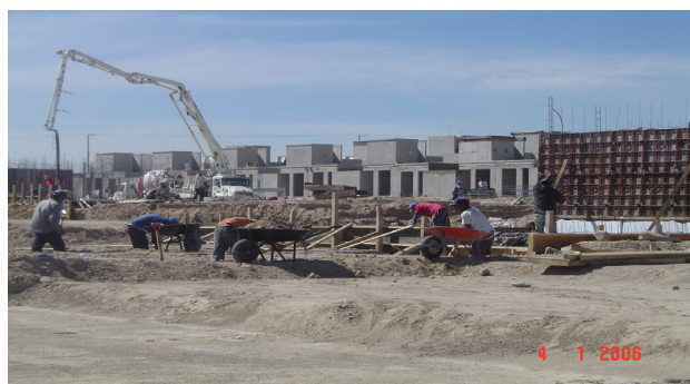
Figura 3. Vivienda de concreto sostenible y sismorresistente
