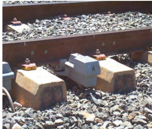
Figura 3. Detector de ejes calientes
