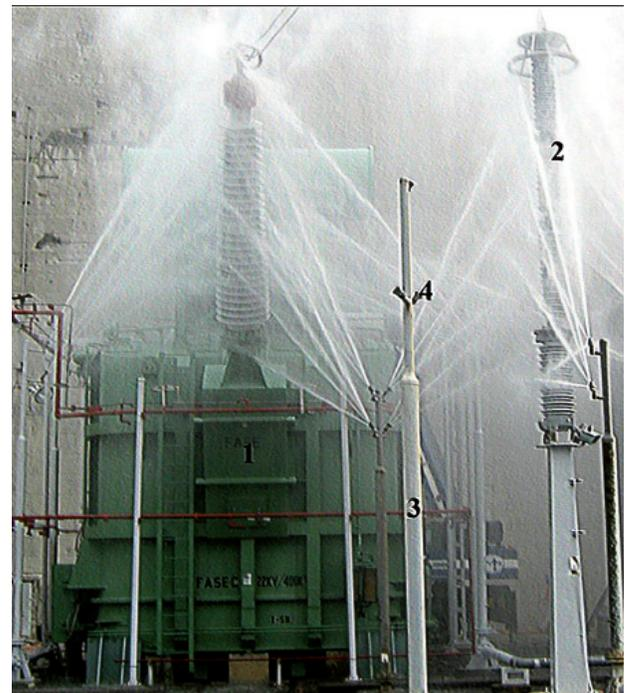
Figura 3. SLTFAP funcionando sobre un transformador monofásico de 300 MVA marca IEM con su pararrayo. 1) transformador marca IEM de 300MVA, 2) pararrayo del transformador, 3) poste de lavado y 4) boquilla de lavado
