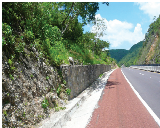
Figura 10. Aspectos del talud analizado
