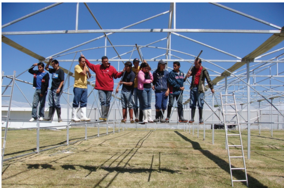
Figura 8. Estructura de invernadero terminada y cargada
