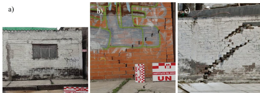
Figura 2. Daños observados en viviendas de mampostería afectadas por grietas en el suelo
