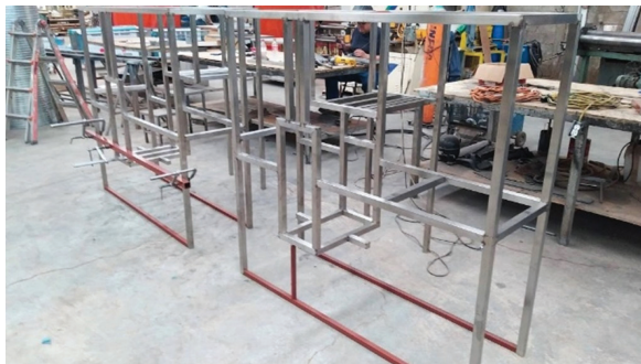
Figura 5. Fabricación de la estructura
